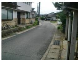
② 側溝にグレーティング等が無く横断児童の待機スペースが狭い。天徳寺方面からの車両一時停止の規制表示が消えかけている。
