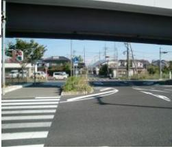
②時速30km/hの規制の路面表示が消えかけている。
