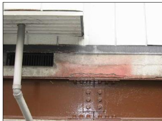
柱の破損
