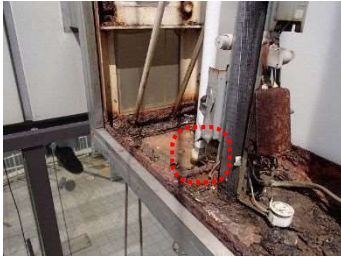
蛍光灯のホルダーが破損した状態
