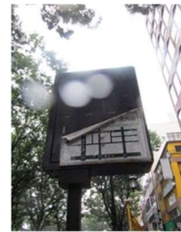
シート材がはがれかかった状態
